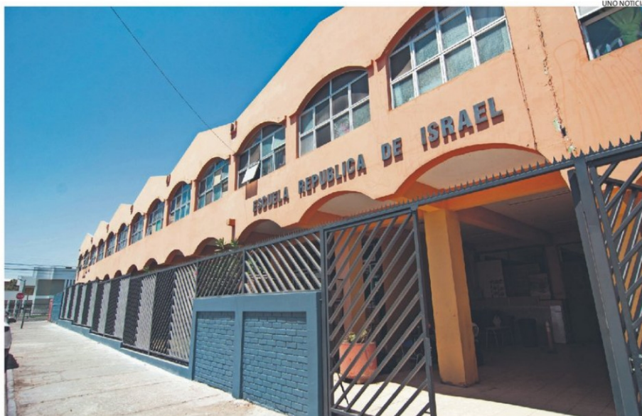
EL SLEP CHINCHORRO INFORMÓ QUE SEGUIRÁ MONITOREANDO EL CIERRE TOTAL DE LAS OBRAS DE MANERA RIGUROSA EN LA ESCUELA.
