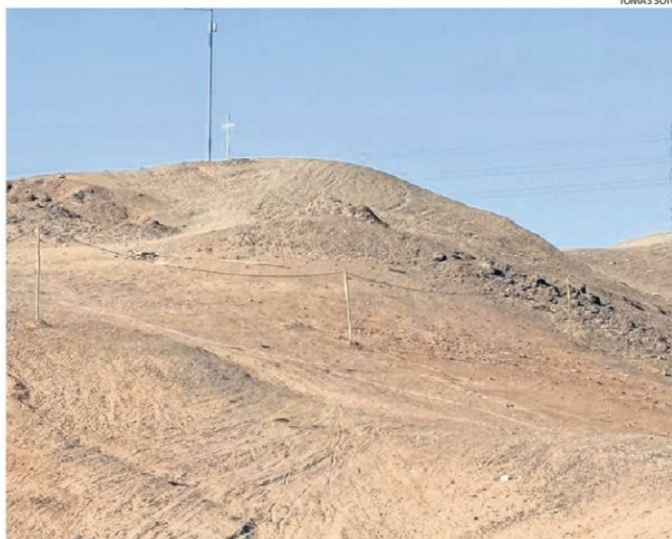
EL CABLE RECORRE VARIOS METROS Y DA SUMINISTRO ELÉCTRICO A UNA TOMA DEL SECTOR.
