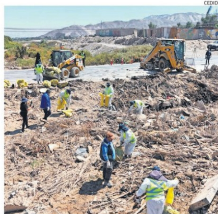
PERSONAL DEL MUNICIPIO TRABAJANDO EN EL RETIRO DE ESCOMBROS.
