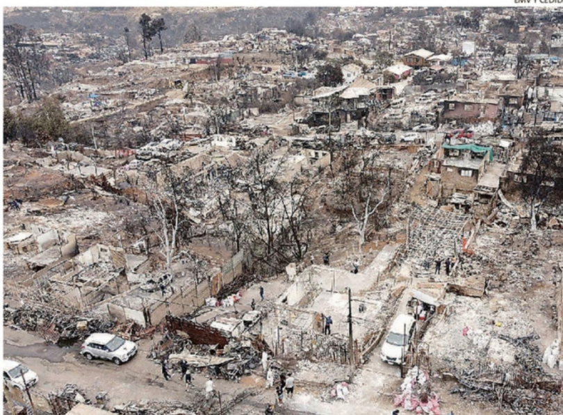
QUERRELA BUSCA QUE SE ACLARE, ENTRE OTRAS COSAS, EL PAGÓ DE SOBREPAGOS EN DEMOLICIONES.
