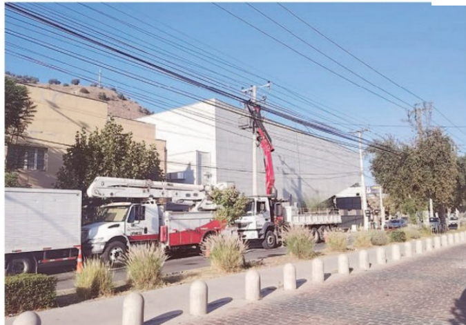
LA INSTALACIÓN DEL EMPALME ES UNA DE LAS TAREAS EN EJECUCIÓN.
