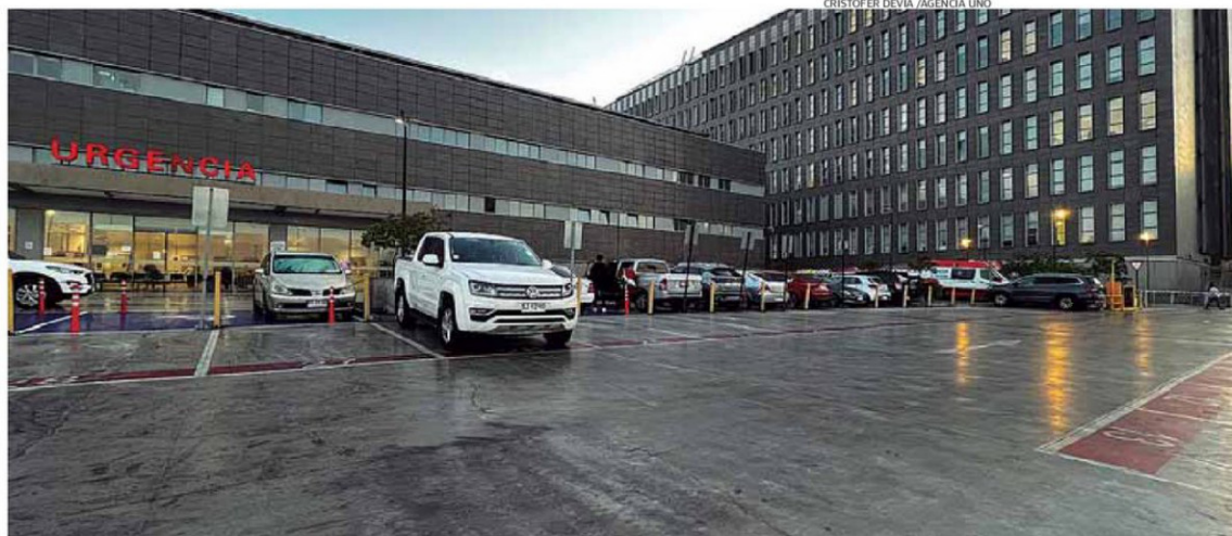
LA CONCESIÓN DEL HOSPITAL REGIONAL COMENZÓ EN 2018.
