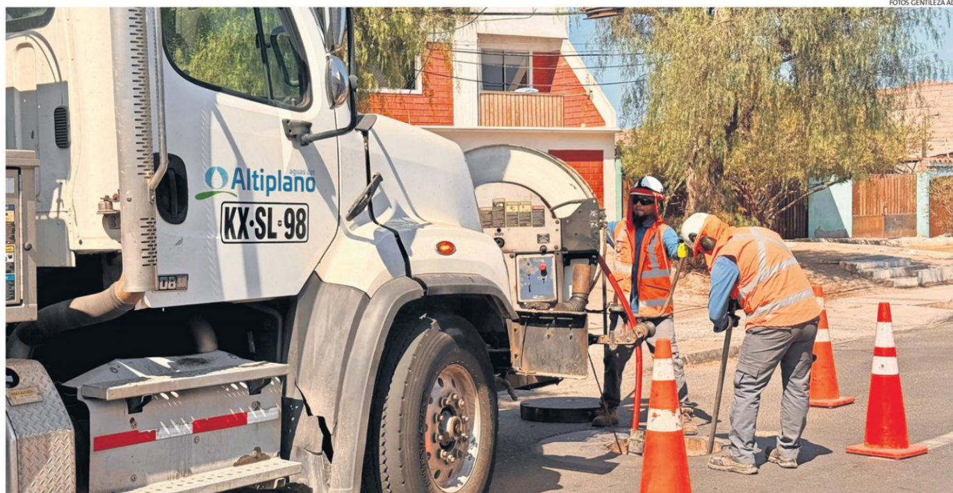
LA SANITARIA REALIZA UN INTENSO TRABAJO SEMANAL PARA RETIRAR ELEMENTOS QUE ESTÁN EN LA RED DE ALCANTARILLADO Y QUE GENERAL REBASES. ELEMENTOS QUE NO DEBERÍAN ESTAR.
