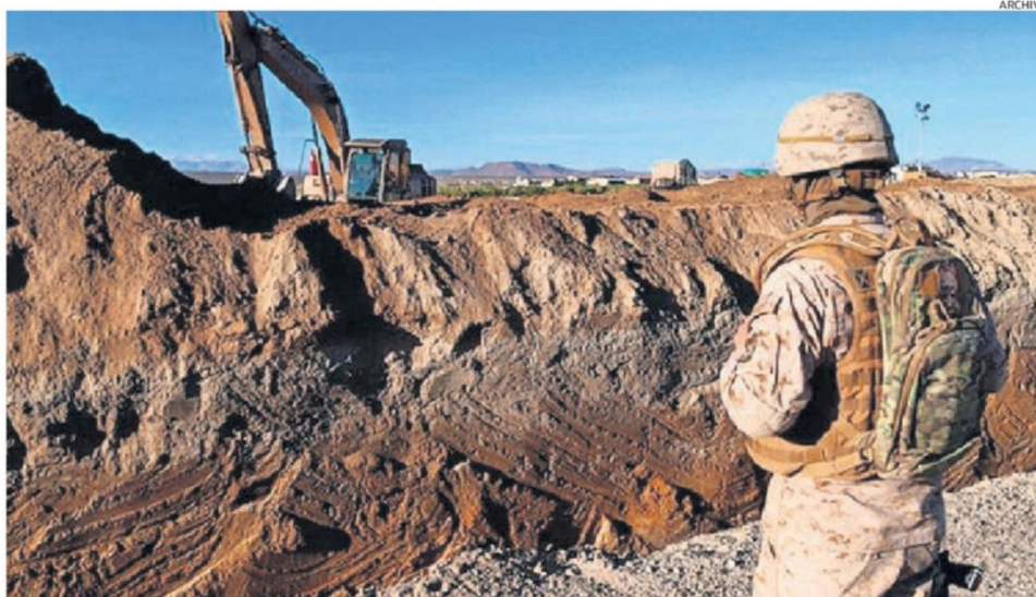
LAS OBRAS DEL PLAN ESCUDO FRONTERIZO COMENZARÍAN ESTE LUNES.
