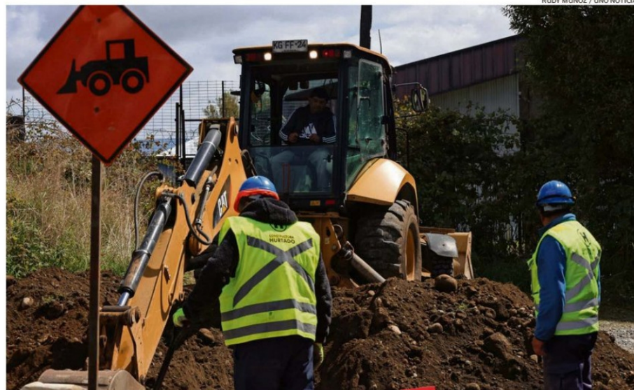
LAS FAENAS INVOLUCRAN EL DESPLIEGUE DE AL MENOS 20 TRABAJADORES Y MAQUINARIA PESADA PARA TRANSFORMAR VÍAS DE RPIO A HORMIGÓN.
