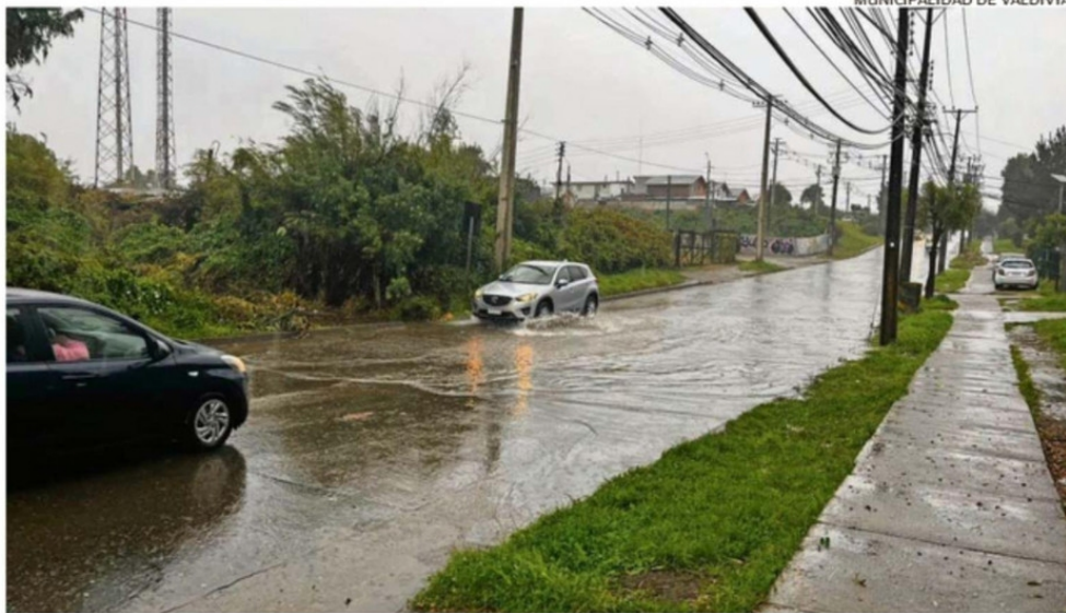
CIRCUNVALACIÓN SUR CON BLEST GANA, FUE UNO DE LOS SECTORES QUE SE ANEGÓ POR LA LLUVIA.
