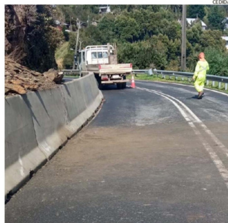
EL CAMINO A MAICOLPUÉ SUFRIÓ DESLIZAMIENTOS DE TIERRA.
