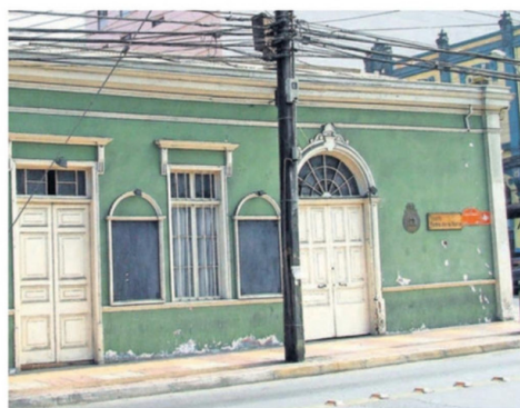
TEATRO PEDRO DE LA BARRA ANTES DE SU REMODELACIÓN ACTUAL.
