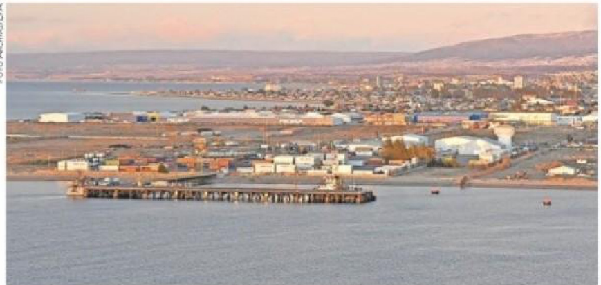
La Empresa Portuaria Austral realizará uno de sus mayores endeudamientos para avanzar en la mejora del muelle Mardones.
