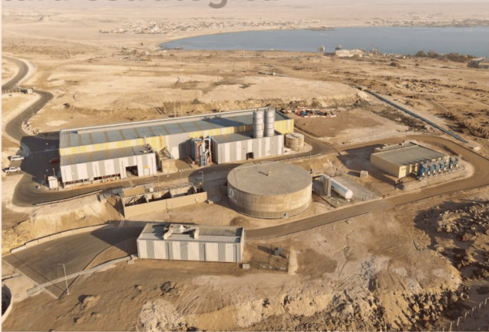
Planta Desaladora de Nueva Atacama en Caldera.
