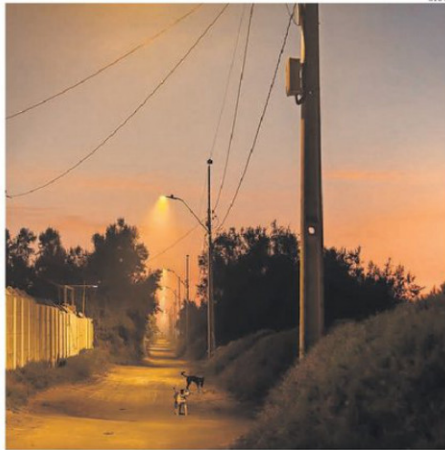
SE INSTALARON 19 LUMINARIAS LED EN EL SECTOR.
