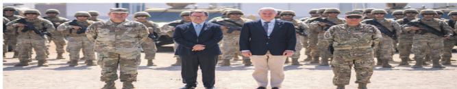
El presidente José Antonio Kast encabezó el inicio de las obras de la primera zanja en la frontera con Perú, en el marco del denominado "Plan Escudo Fronterizo".
