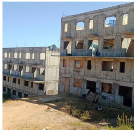
ESTADO ACTUAL DE CÓMO QUEDARON LAS OBRAS.
