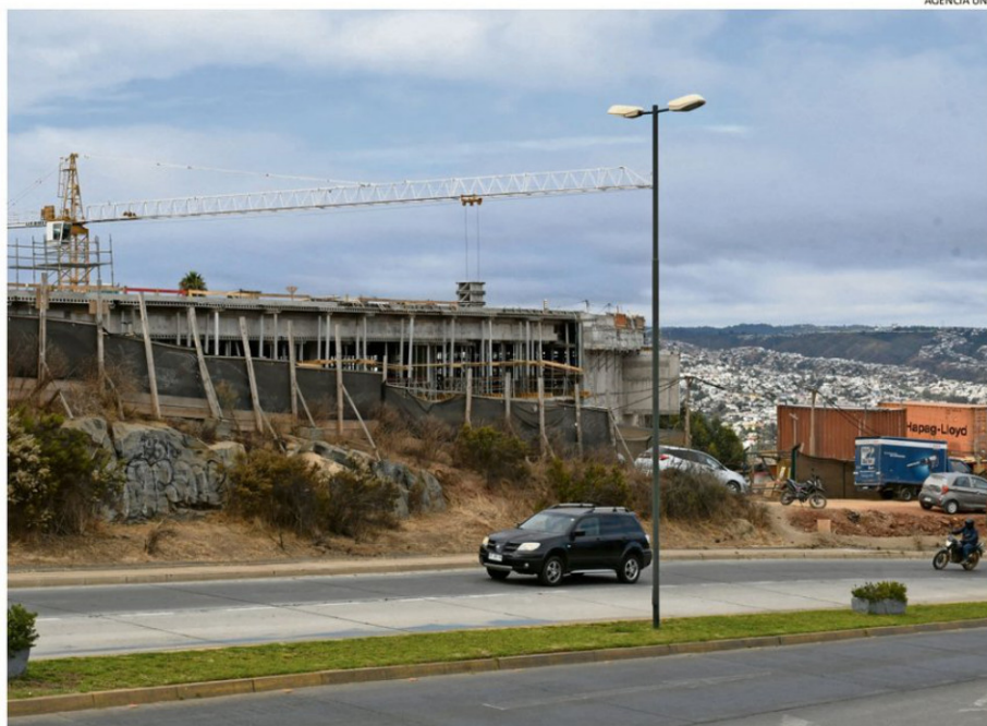
EN AV. PADRE HURTADO HAY OBRAS EN EJECUCIÓN Y RECINTOS DE ALTA AFLUENCIA PÚBLICA, TANTO DE VEHÍCULOS COMO DE PERSONAS.
