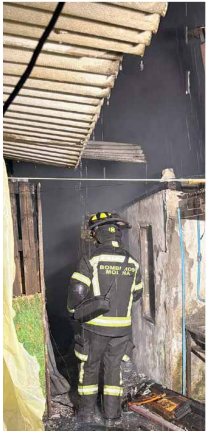
Llamas destruyeron varias piezas de una vivienda. Damnificados fueron trasladados a una sede social.
