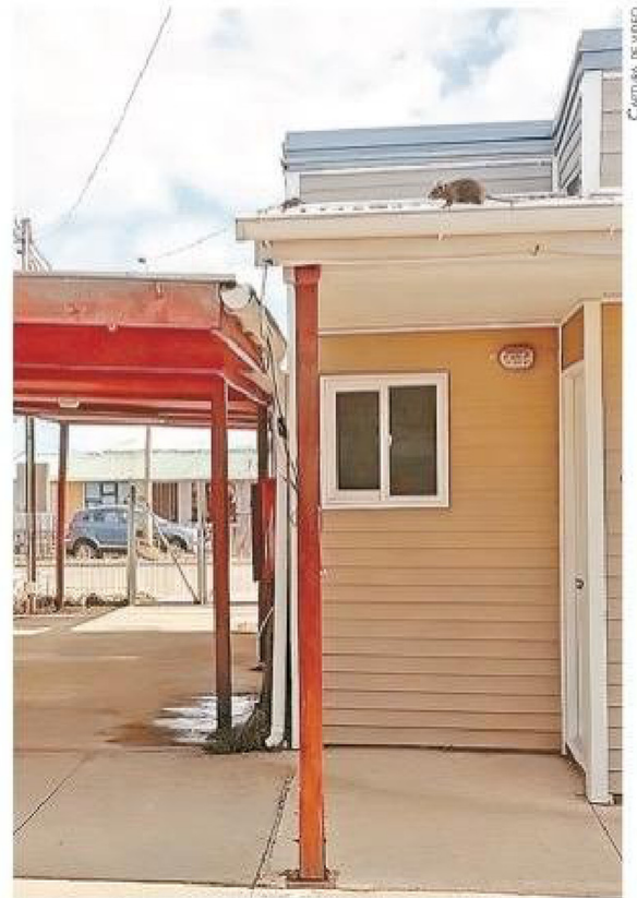
"El alcantarillado es precisamente para evitar la presencia de roedores y otras especies dañinas", resumió una fuente de Aguas Magallanes.
