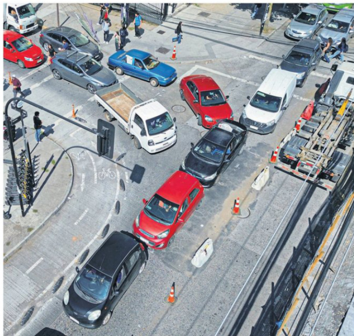
Una vez que finalicen las obras en el tramo intervenido, se cortará el tránsito en dirección a Callao.
