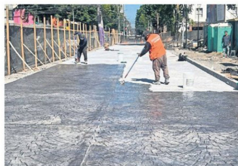
El viernes se aplicaron productos para sellar el pavimento.
