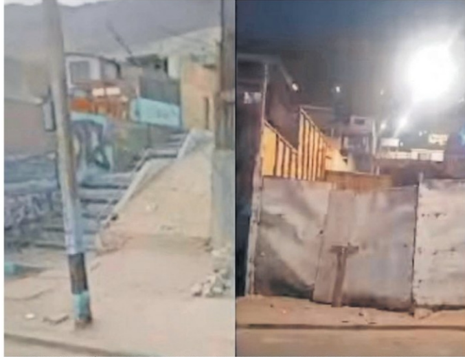
A LA IZQUIERDA ESTÁ LA ESCALERA ANTES DE SER INTERVENIDA. A LA DERECHA ES COMO LUCE HOY
