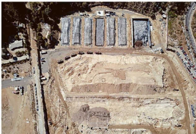
TRABAJOS SE INICIARON HACE 18 MESES EN EL SECTOR.
