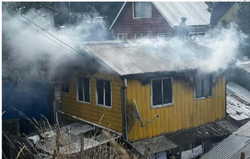
EL SEGUNDO PISO DE LA VIVIENDA RESULTÓ CON DAÑOS TOTALES.
