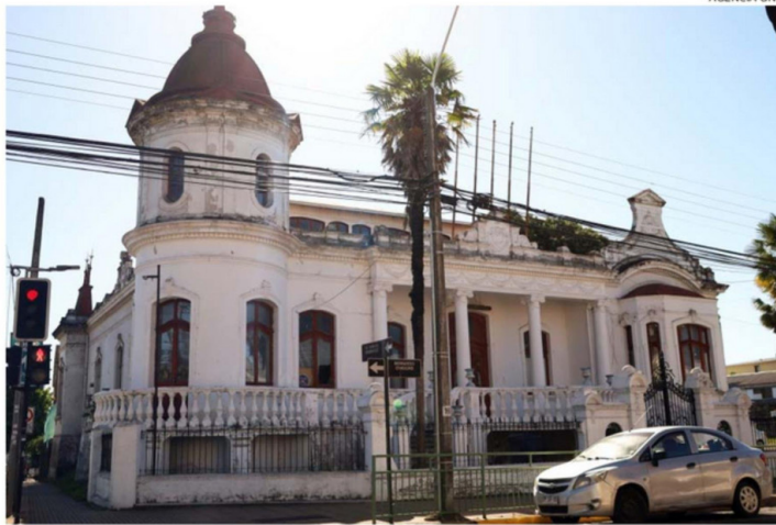
LA CASONA CALÇUMBIDE DATA DE 1910, AUNQUE FUE RECONSTRUIDA EN 1930. HOY LUCE DETERIORADA.
