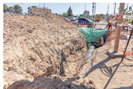
OBRAS AVANZAN RÁPIDAMENTE.
