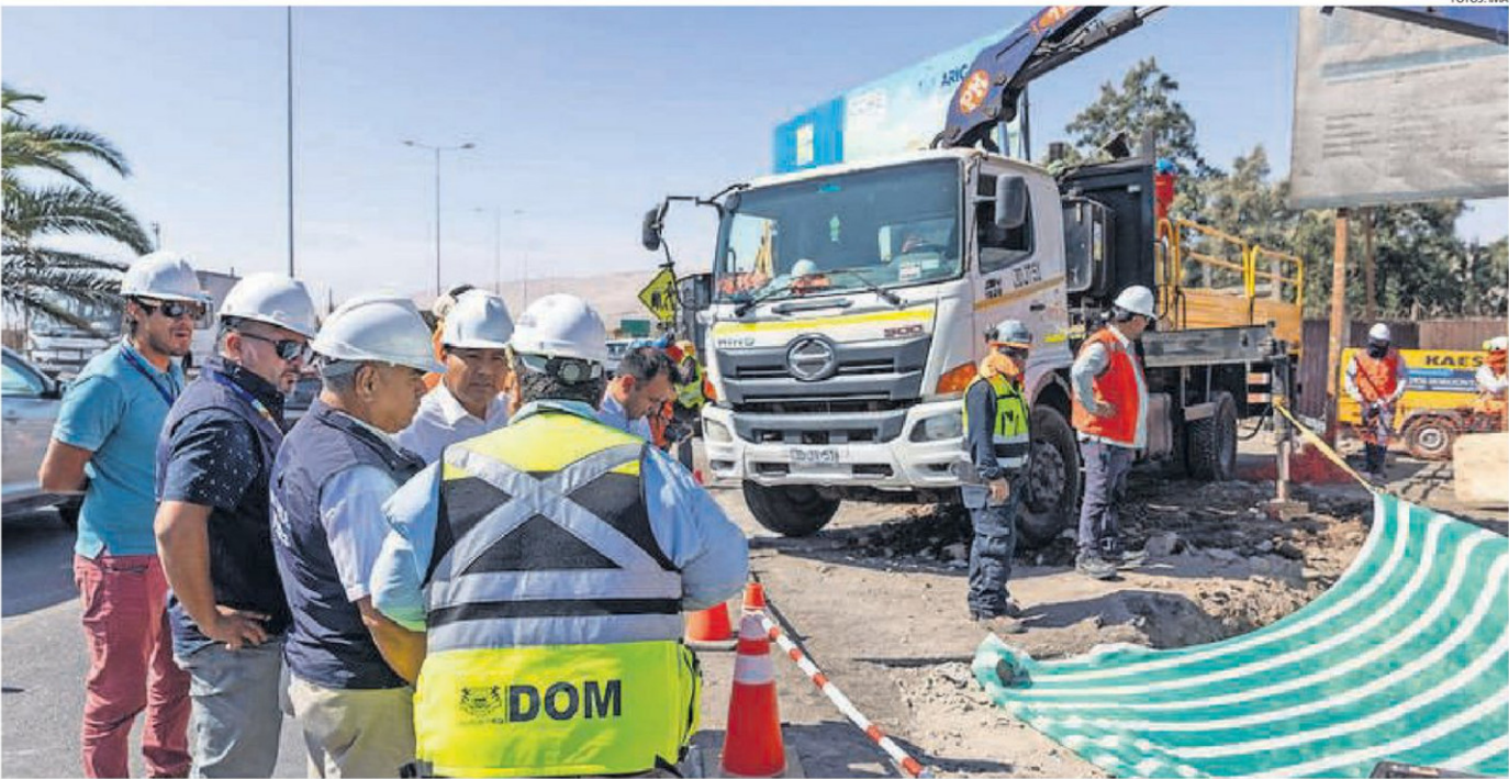
EL PROYECTO CONTEMPLA LA INSTALACIÓN DE SEIS KILÓMETROS DE POSTACIÓN CON 168 POSTES DE ACERO GALVANIZADO, 336 LUMINARIAS LED, Y 6 MIL METROS DE CANALIZACIÓN Y CABLEADO.
