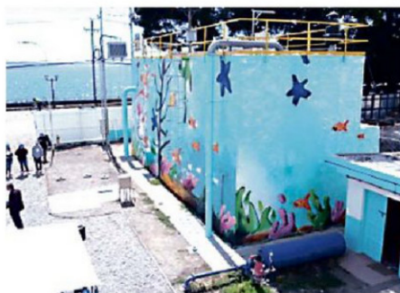
Estanques de tormenta de Puerto Varas
