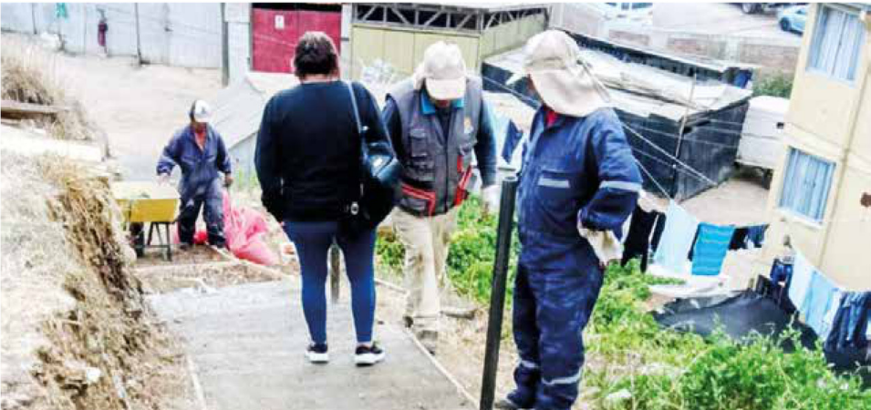
Durante el proceso, habitantes del sector acompañaron activamente el desarrollo de los trabajos, entregando apoyo a las cuadrillas municipales, reflejando el sentido de comunidad.
