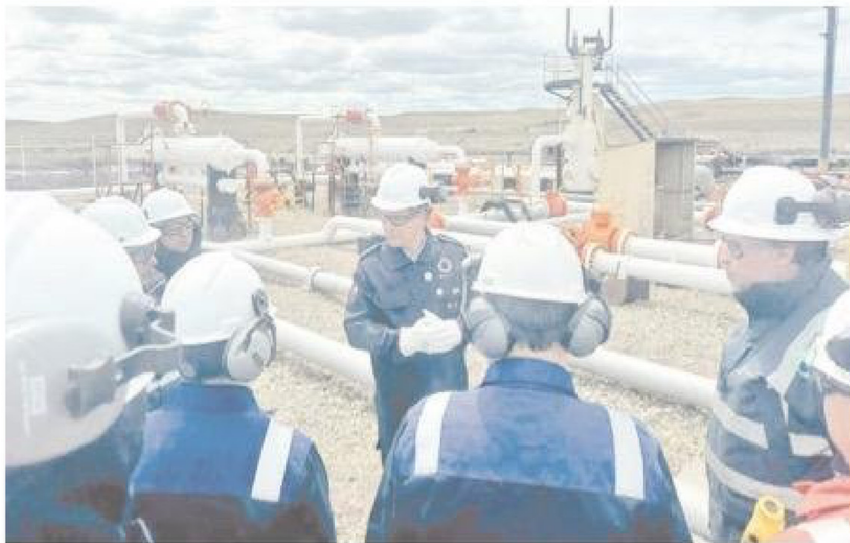
En diciembre pasado, el gerente general de Enap, Julio Friedmann, visitó la Planta Posesión, días después de la inflamación de un gasoducto.
