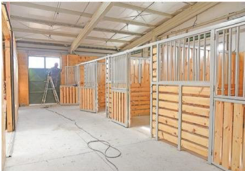
La construcción de las caballerizas de la nueva Comisaría de Carabineros.
