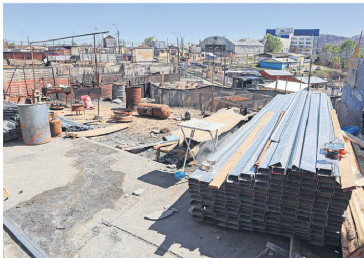
Uno de los sectores con más complicaciones para iniciar obras fue Vipla, por las condiciones de la zona.
