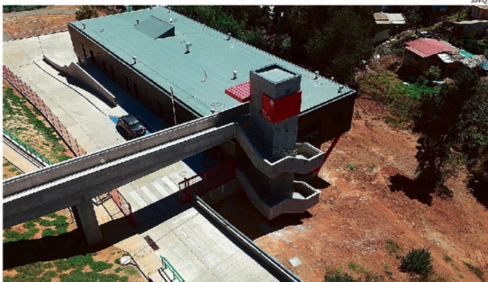
LA SEMANA PASADA EL SERVICIO DE SALUD RECEPCIONÓ CONFORME LA INFRAESTRUCTURA.
