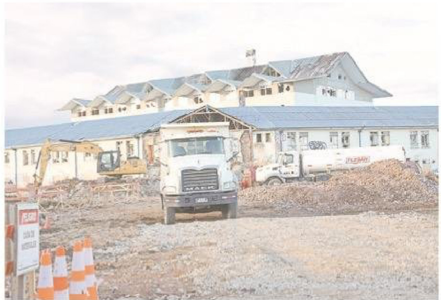
Avanzan las faenas de demolición del exhospital hacia calle Angamos.
