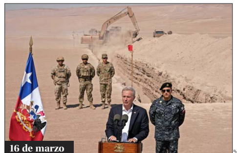
16 de marzo En Arica , el mandatario supervisó directamente el inicio de la construcción de zanjas en la frontera que buscan dificultar el ingreso irregular al país.
