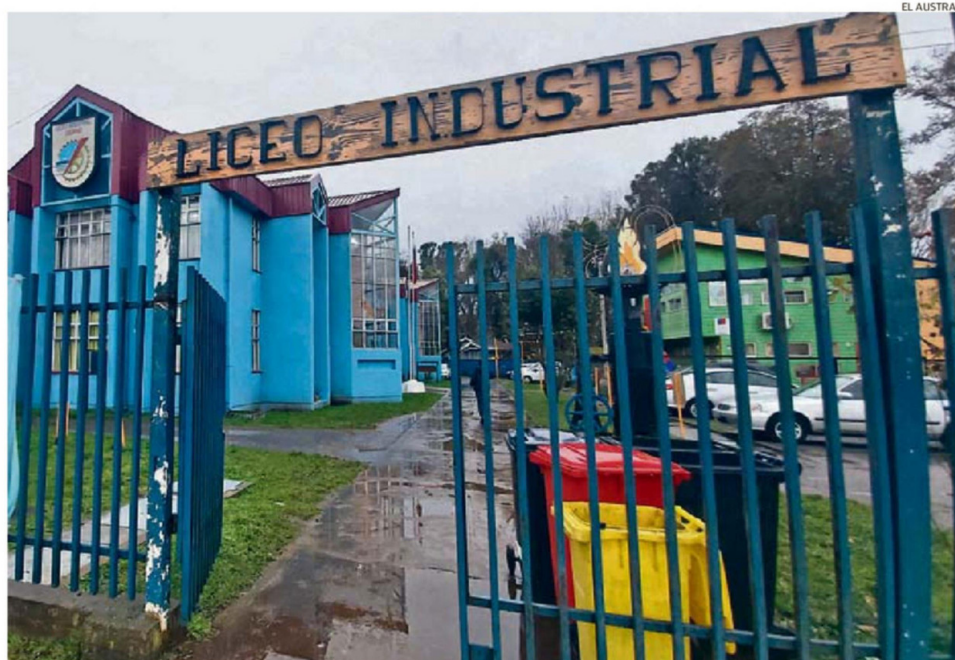
DENTRO DEL TERRENO DEL LICEO INDUSTRIAL SE ENCUENTRAN LAS INSTALACIONES DE LA DIRECCIÓN DE SEGURIDAD PÚBLICA, QUE ESTÁN EN RIESGO.
