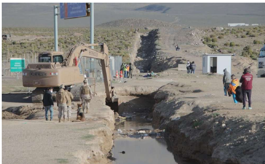
Las obras iniciales ya están en curso, con la excavación de zanjas en un segmento significativo de los puntos más sensibles del altiplano.
