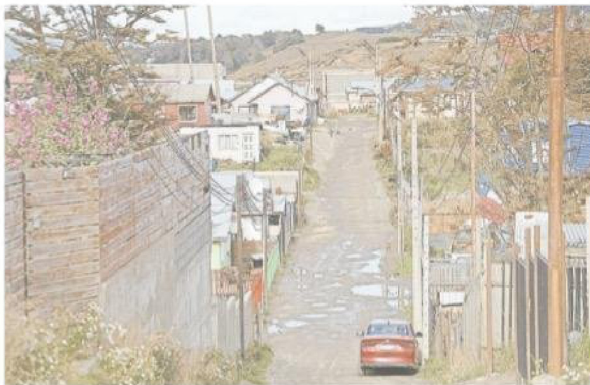
Calles sin pavimentar y con acumulación de agua evidencian las precarias condiciones de tránsito en Pampa Redonda, donde vecinos denuncian años sin soluciones estructurales.
