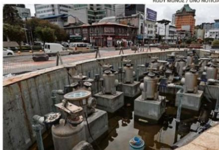
LA PILETA DE LA ERA PAREDES FUE DESTRUIDA DURANTE EL ESTALLIDO.
