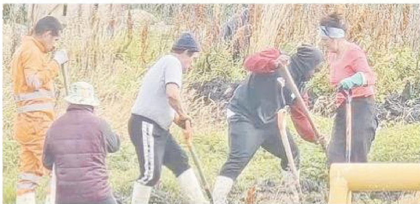
Pobladores captados en pena construcción de una zanja.
