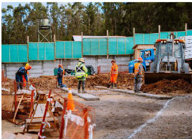
Este proyecto permitirá mejorar el acceso a salud oportuna, reducir traslados a otras comunas y fortalecer la red asistencial local.
