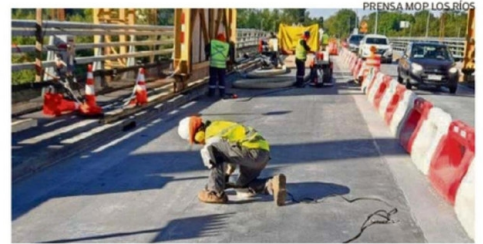
TRABAJOS EN LAS PISTAS SON PARTE DE MEJORAMIENTO DEL PUENTE.
