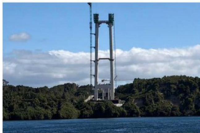
EN EL CANAL DE CHACAO RECORRERÁ LAS OBRAS DEL PUENTE.
