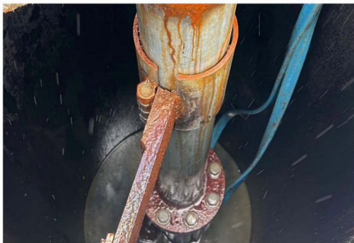
REVISIÓN DE PARTE DE LA ESTRUCTURA QUE ABASTECE DE AGUA A VECINOS DE CURANUÉ.
