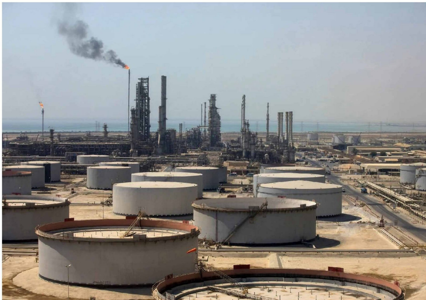
► Refinería de petróleo Ras Tanura de Saudi Aramco, en Arabia Saudita.
