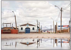
GENERAL LAGOS.— No tiene energía eléctrica y depende de generadores y paneles fotovoltaicos.
