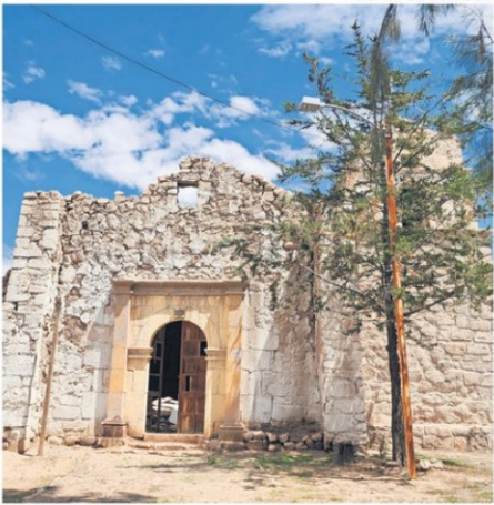
PROYECTAN QUE LAS OBRAS CONCLUYAN EN SEPTIEMBRE DE ESTE AÑO.
