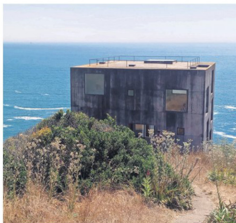
Residencias de una o dos semanas son las que están pensadas para la temporada 2026 de Casa Poli.
