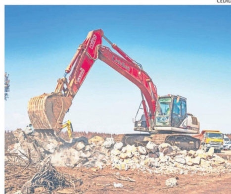
RETIRO DE ESCOMBROS DESDE EL SECTOR PUNTA DE PARRA.
