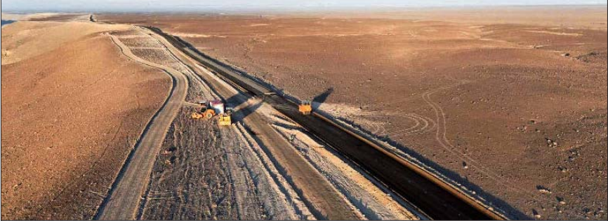
TRABAJOS. — Las obras de mantenimiento comenzaron en enero y deberían finalizar en junio. Por norma, un arqueólogo debería supervisar los trabajos.
