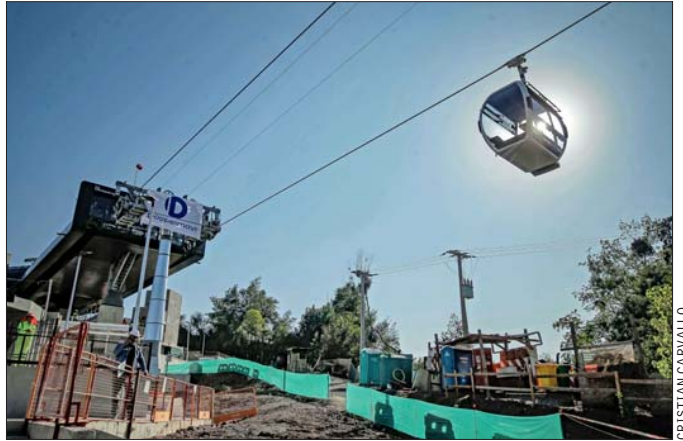
El teleférico contará con 121 cabinas. Ayer partieron las pruebas.
